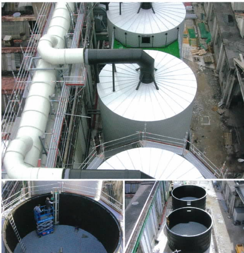
Oben: Anschluss der Biowäscher an die Produktion. Unten: Aufbau und Dichtigkeitsprüfung der Wäscher.
