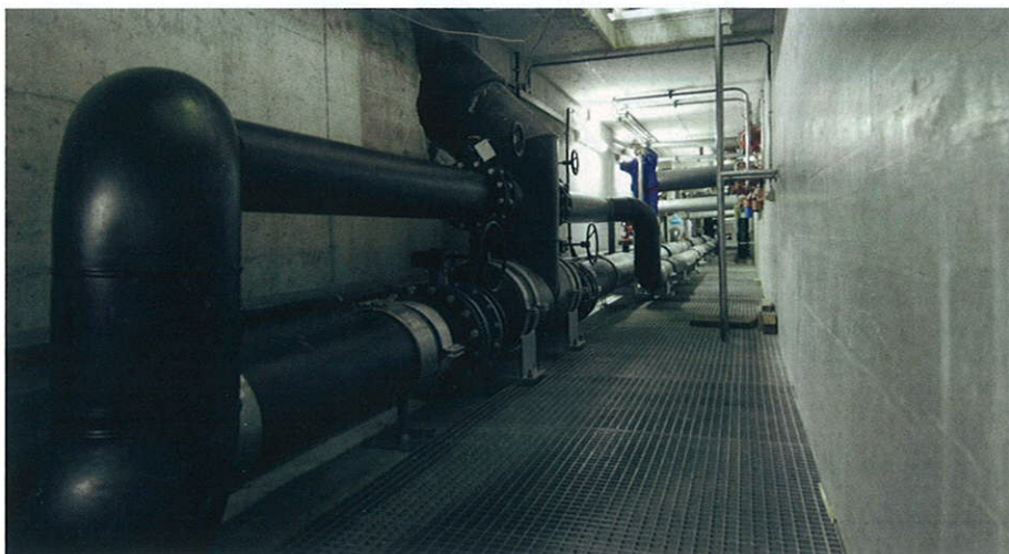
Erneuerung der Kühlwasserleitungen im Kraftwerk Grimsel 2 – die Kraftwerke Oberhasli AG ist eines der führenden Wasserkraftunternehmen der Schweiz. (Bilder: Colasit)
